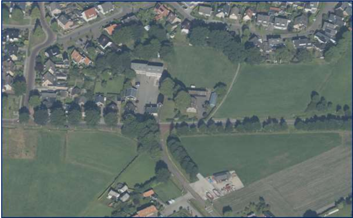
Figuur 2.1: Huidige situatie Vosseboerweg 1 Den Ham (bron: Cyclomedia Streetsmart)
